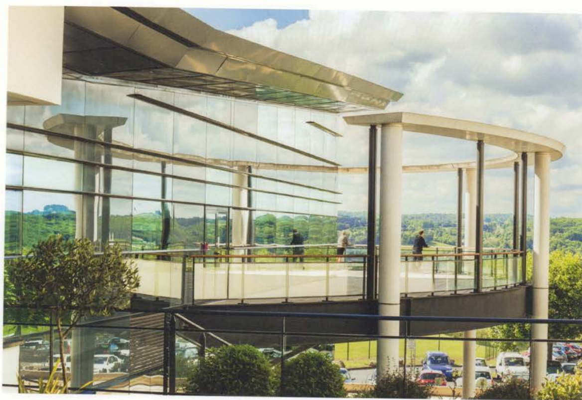
Périgueux, Rotonda spitahului, 2011
