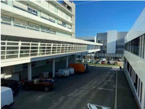
Passerelle vers Madeleine-Brès. Photo: CH du Mans
