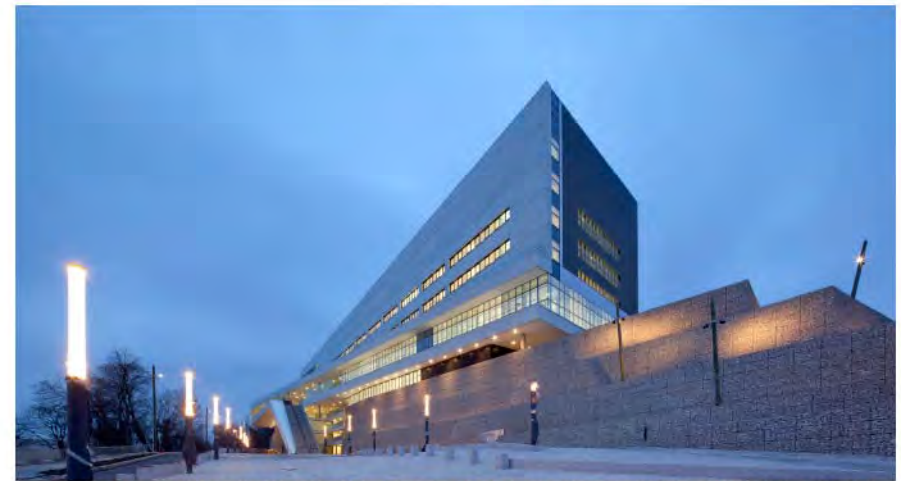
CENTRE HOSPITALIER INTERCOMMUNAL DE VILLENEUVE-SAINT-GEORGES, Villeneuve-Saint-Georges, livré 2013
