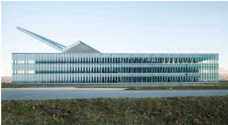
INSTITUT NATIONAL DE L'ÉNERGIE SOLAIRE / CONSEIL GÉNÉRAL DE SAVOIE, Chambéry, livré 2013
